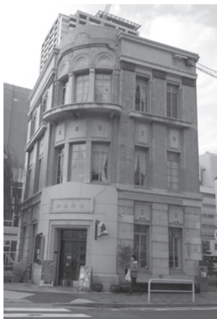
旧加藤商会ビル外観
